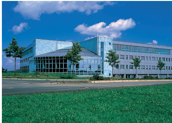
Headquarter Lumberg-Gruppe, Schalksmühle (Deutschland)
