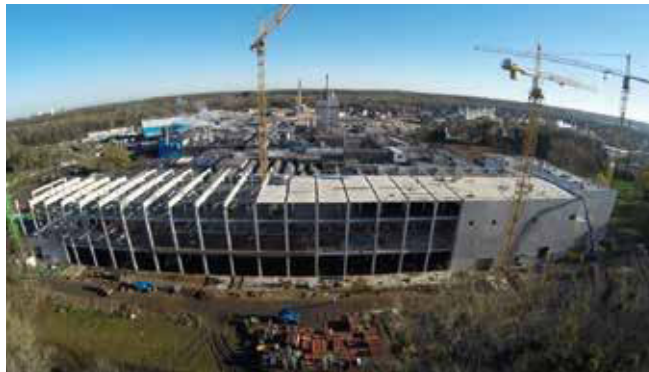
Neubau Papierfabrik SCHOELLERSHAMMER
